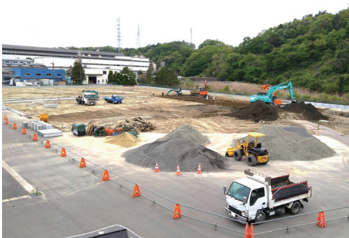
いわき工場の建設工事の様子
